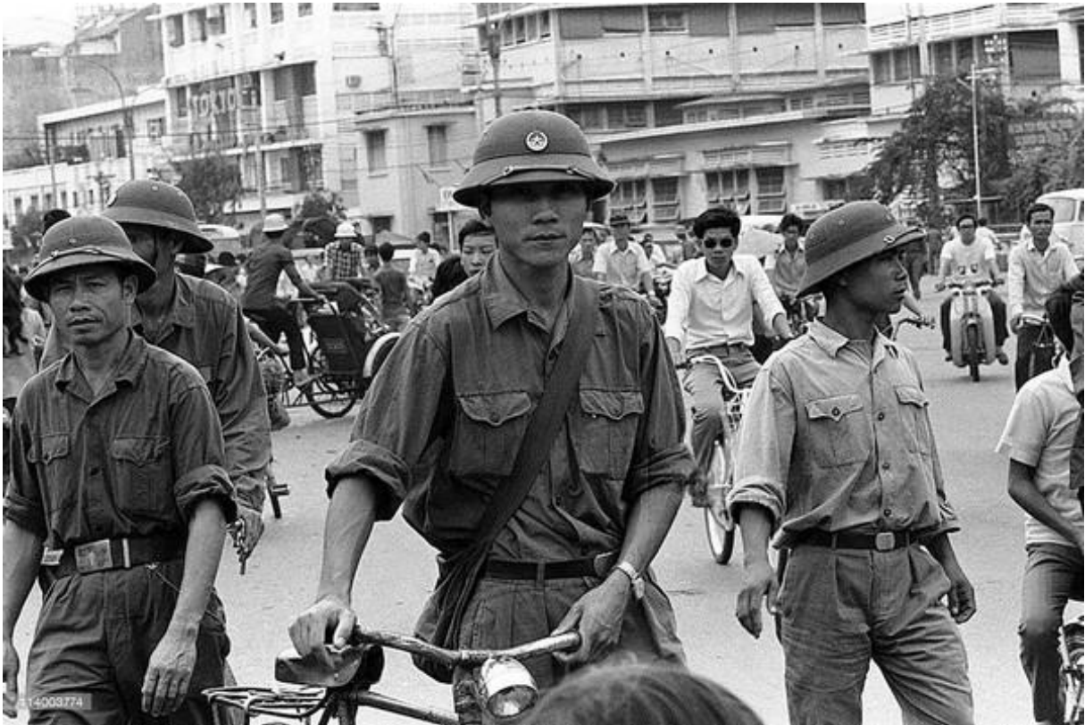
Đường Lê Lợi, Sài Gòn, tháng Năm 1975
